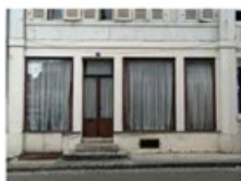
Façade de l'immeuble avant/après ▶▶
