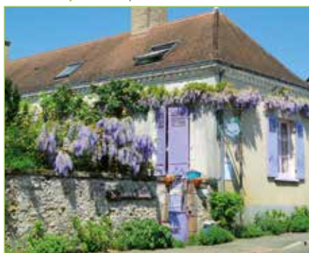
▲ Plantes vivaces en pied de mur | signalent l'hébergement
