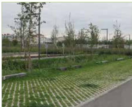
▲ Revêtement pavés joints enherbés | discret
