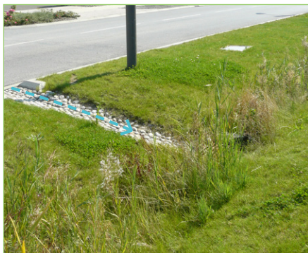
▲ Bordure interrompue | guide l'eau à la noue
