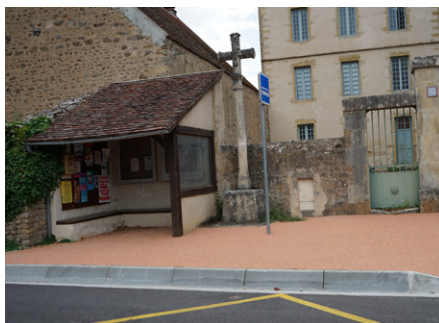
Arrêt de bus | bordure réglementaire de 19 cm
