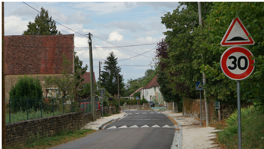
Plateau, problème de conception ou réalisation | bordures hautes empêchent la traversée des PMR
