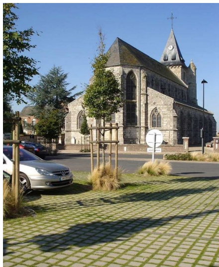
▲ Pavés joints enherbés sur un stationnement
