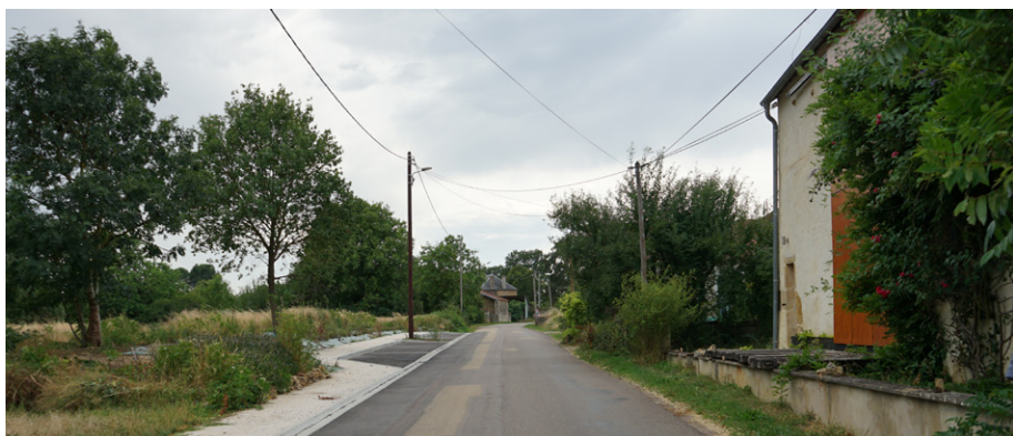
Aménagements des abords | bordure abaissée stationnement longitudinal talus planté
