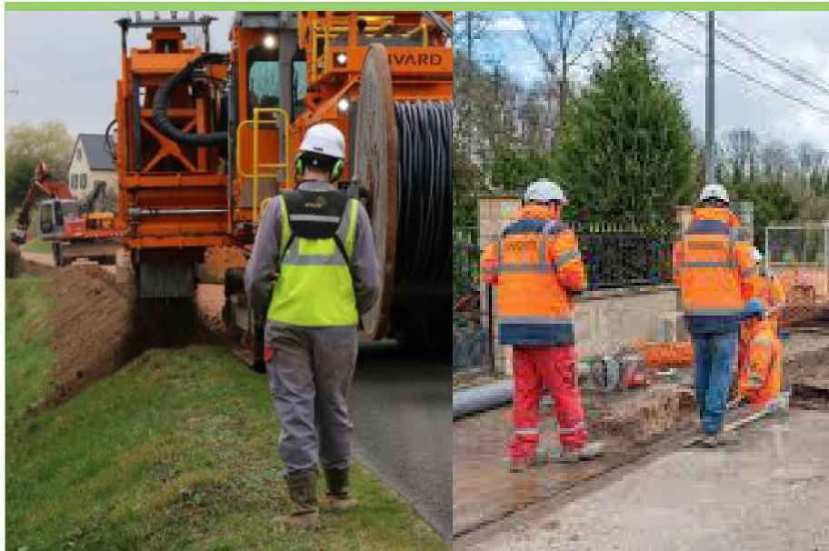
▲ Réalisation d'un chantier de voirie
