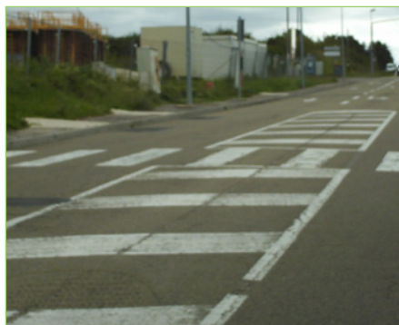
▲ Terre-plein central | marquage au sol
